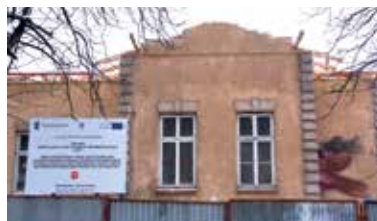
Remont budynku przy ul. Kapitulnej 2
